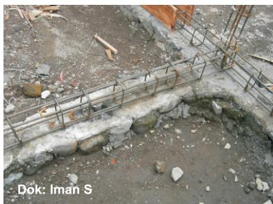
Foto sambungan Kolom dan balok pengikat/sloof
