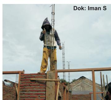
Beton dirojok dengan besi tulangan atau bambu agar tidak ada yang keropos
