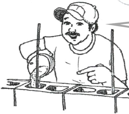
Al momento de colar el concreto fluido deberá llenarse hasta la mitad de la celda a modo de crear un anclaje con el siguiente llenado. Esto evitará que la unión de los dos llenados coincida con las sisas y genere grietas horizontales.
