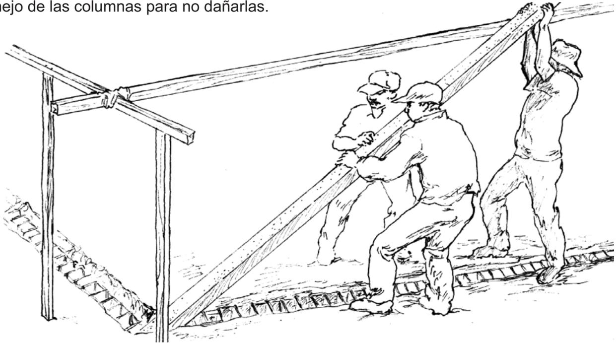
El castillo permite apuntalar adecuadamente las columnas y así mantener la exactitud que requiere el sistema. Es necesario que la verticalidad de las columnas se revise con plomada, ya que hacerlo con nivel de caja puede generar errores.
